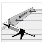
在塑料薄膜上安装踢脚板,塑料薄膜从地板下起向墙上铺展。切勿将踢脚板贴附在地板上。此方法为地板在踢脚板下留有了膨胀和收缩的余地。
